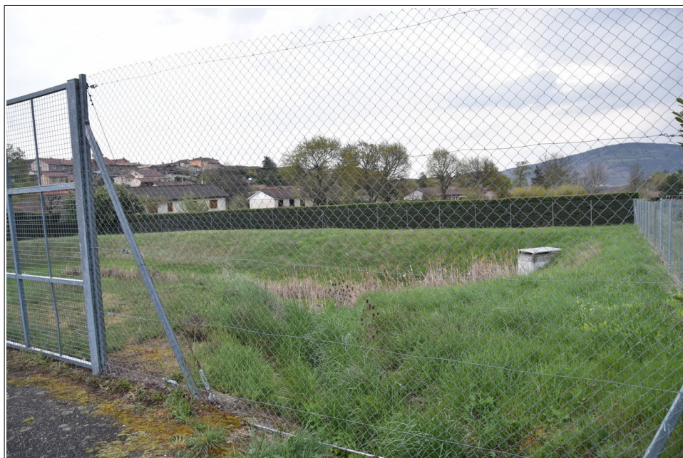
Figure III 2: bassin d'orage de la salle polyvalente.
